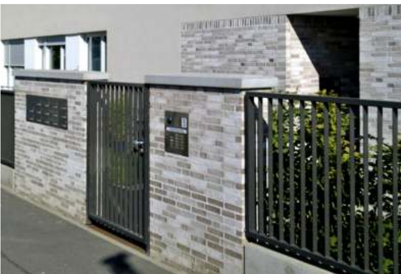
Abb. 28 Einfriedung mit Maueranteil, Zaun und Hecke
