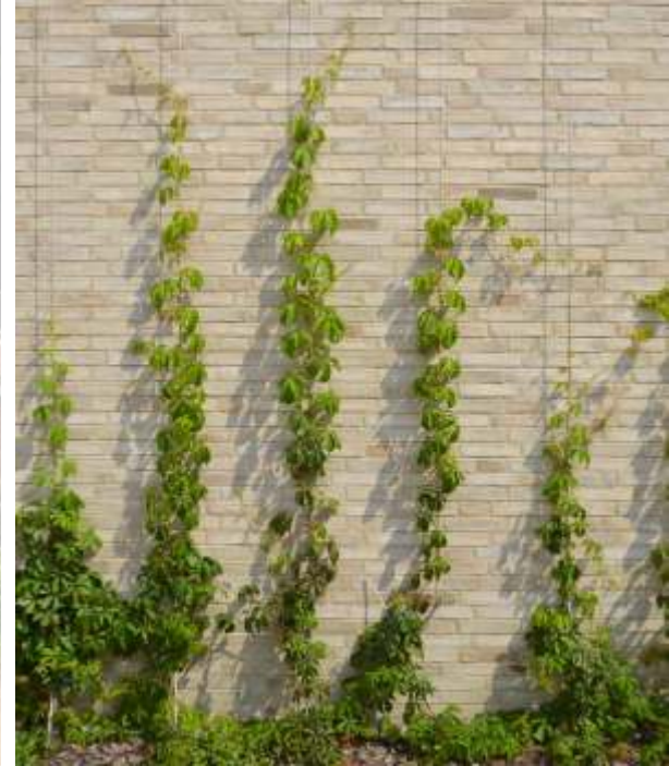
Abb. 71 Begrünung von Mauern und Wänden
