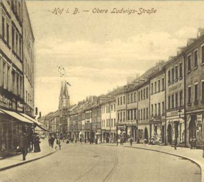
Abb. 44 Geschlossener Straßenzug in Hof i. B.
