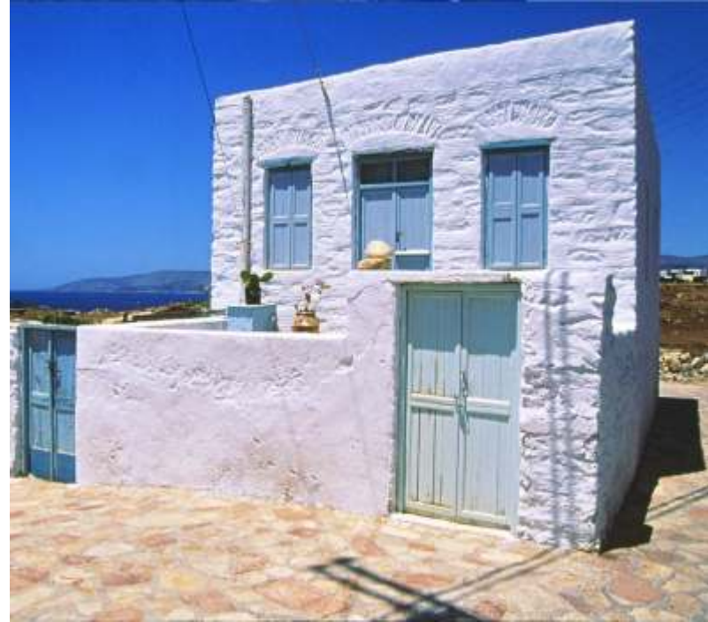
Abb. 2 Haus auf den Kykladen mit Vorhof
